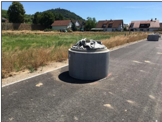
Abbildung 1: Schachtring zur Sicherung der Baumstandorte
