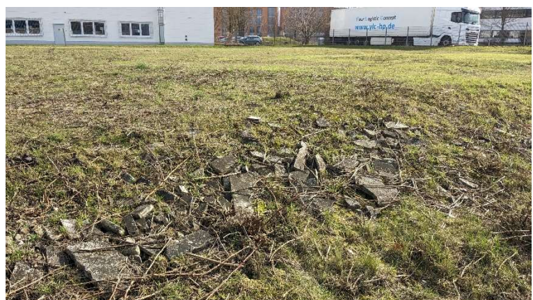
Abbildung 6: Westlicher Böschungsbereich der Wiesenfläche W 3 mit Aushärtungen oder Befestigungsanteilen der ehemaligen Steinschleifschlammbecken
