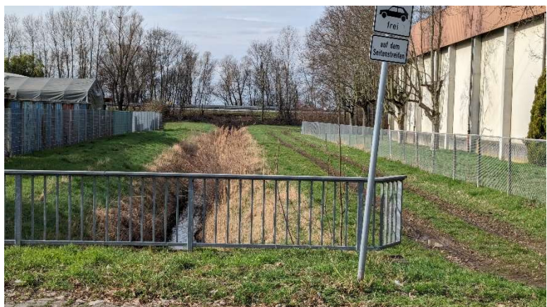
Abbildung 11: Südlich des Plangebiets verlaufender Grasweg und Beigraben
