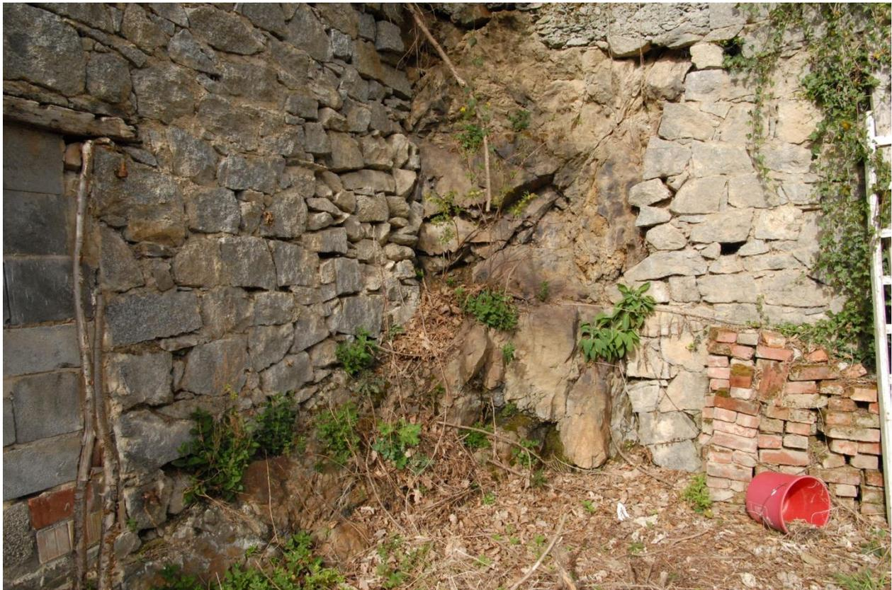
Foto 5 Spalten im Natursteinmauerwerk
