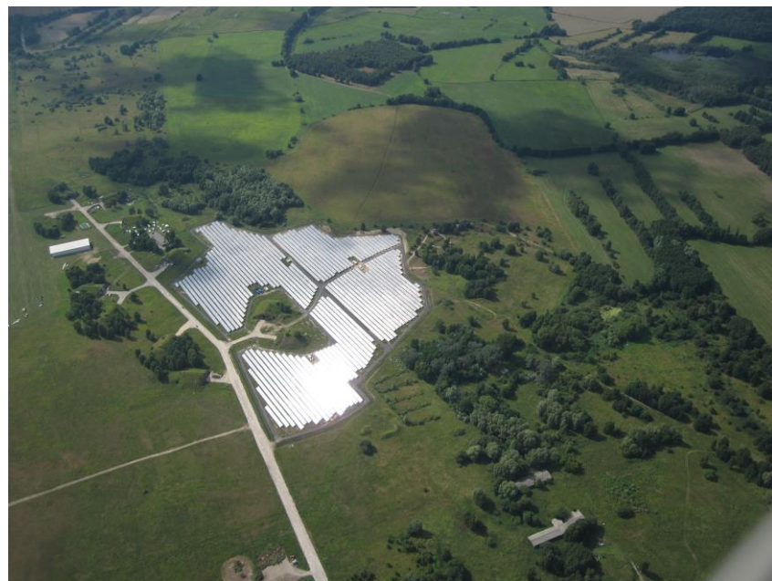
Bild 10: Sonnenlichtreflexion einer PV-Freiflächenanlage
