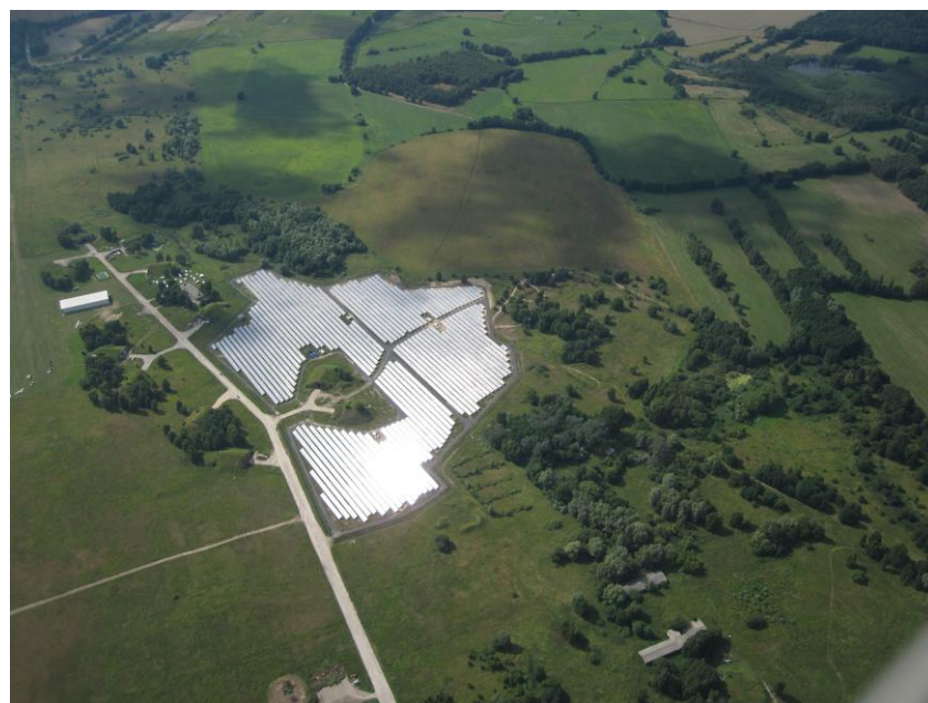
Bild 7: Sonnenlichtreflexion einer PV-Freiflächenanlage
