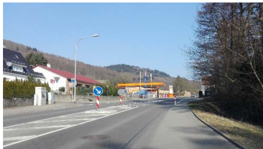
Foto 4: Blick zum Vorhabenstandort, aus Kirschhausen kommend
