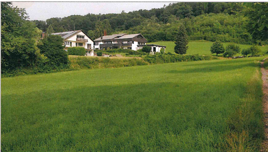
Abb. 1: Blick auf das Baugrundstück.
