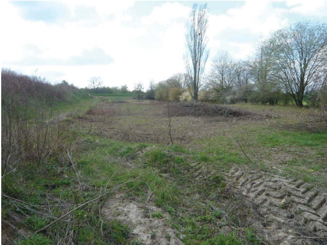
Foto 6 Westliche Dammseite und Brachfläche zwischen Damm und Hecke
