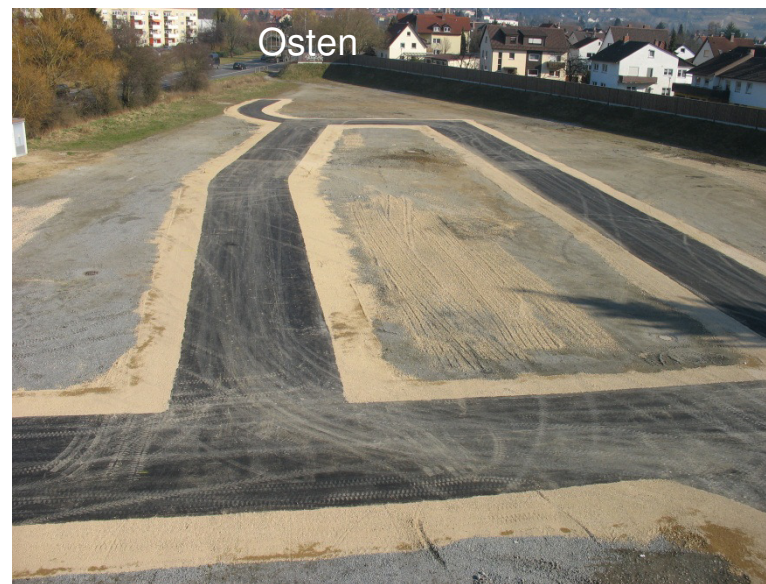
Europaplatz Ostbereich mit befestigtem Rundweg. Straßen dürfen nicht beschädigt werden.
